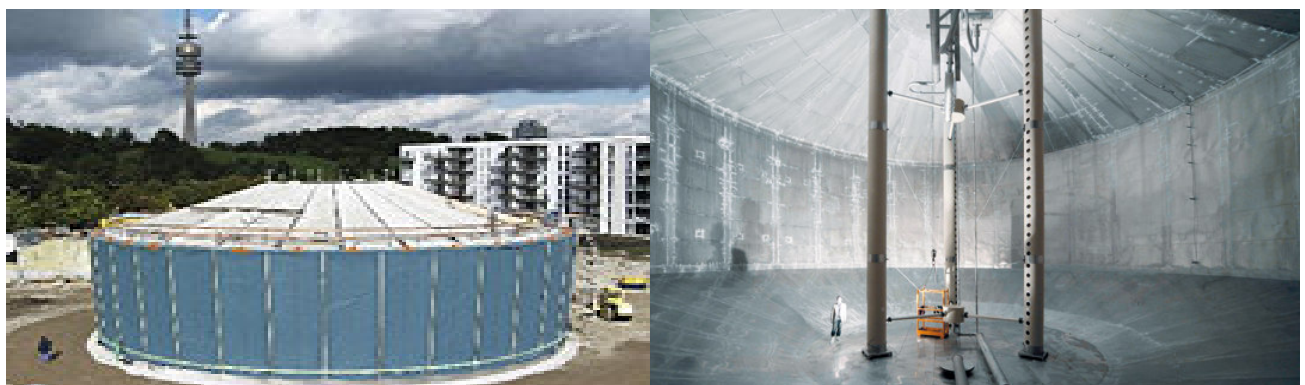
Wärmespeicher in Friedrichshafen (1996), 12.00 m 3 , Durchmesser 32 m, Höhe 12 m
