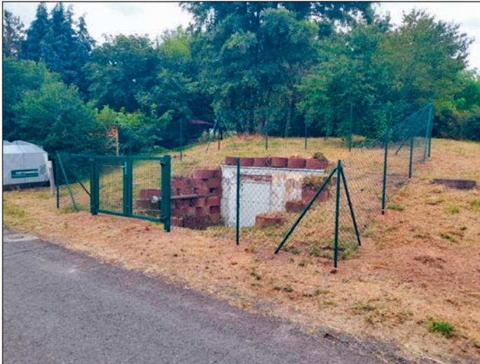
Nach der Teilung der Grundstücke und der Beseitigung des Zaunes hatte der städtische Bauhof zunächst einen Bauzaun als Absturzsicherung um den Eingang errichtet. Inzwischen hat der Bauhof dieses Provisorium durch einen umlaufenden Zaun mit Tor für die Wasserentnahme am Einstieg ersetzt. Jetzt werden noch der Treppenbereich gesäubert und die Verputzarbeiten rund um die Behältertür durchgeführt.
