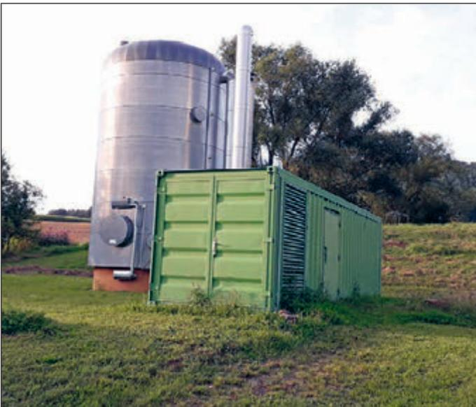
Übergabestation mit Spitzenlastkessel und Pufferspeicher der Nahwärme Josbach
