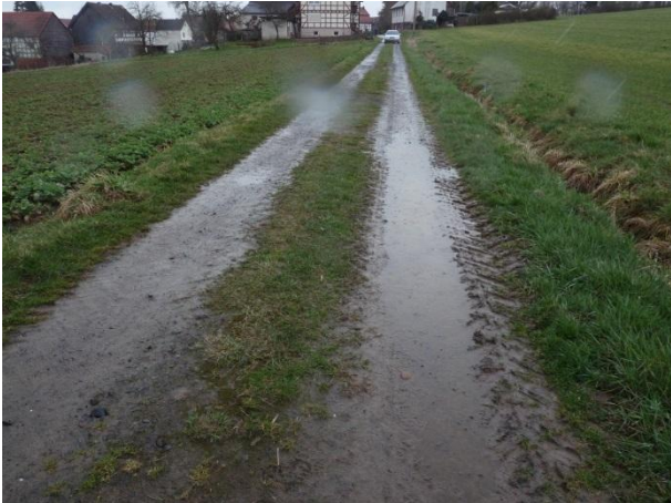
geschotterter Teil des Wirtschaftsweges, die überwiegend grasbewachsenen Wegeränder, Blick nach SO
