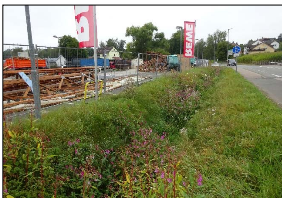
Verkrauteter Entwässerungsgraben (Rauschenberger Bach) nordwestlich des Plangebietes. (eigene Aufnahme 09/2021)
