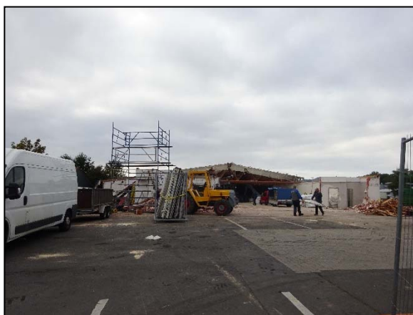
Blick nach Südwesten auf die bestehenden Versiegelungen sowie die Abrissarbeiten. (eigene Aufnahme 09/2021)
