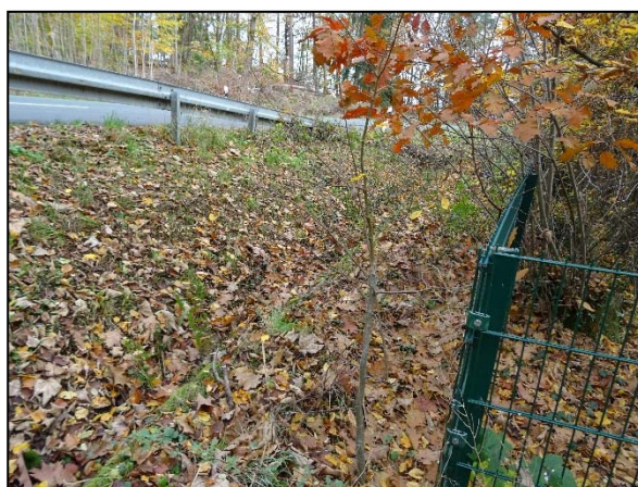
Abb. 11: Entwässerungsmulde nördlich des Plangebietes an der Straßenverkehrsfläche L 3077 (eigene Aufnahme 11/2020)
