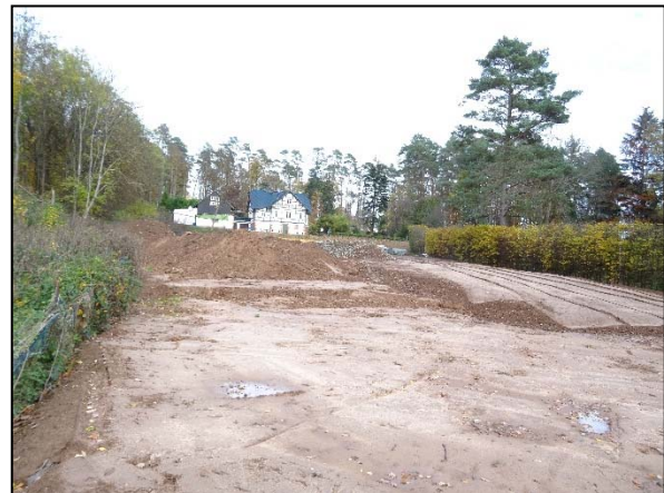
Abb. 8: Blick von Süden nach Norden im südlichen Teil des Plangebietes auf das Gebäude (eigene Aufnahme 11/2020)
