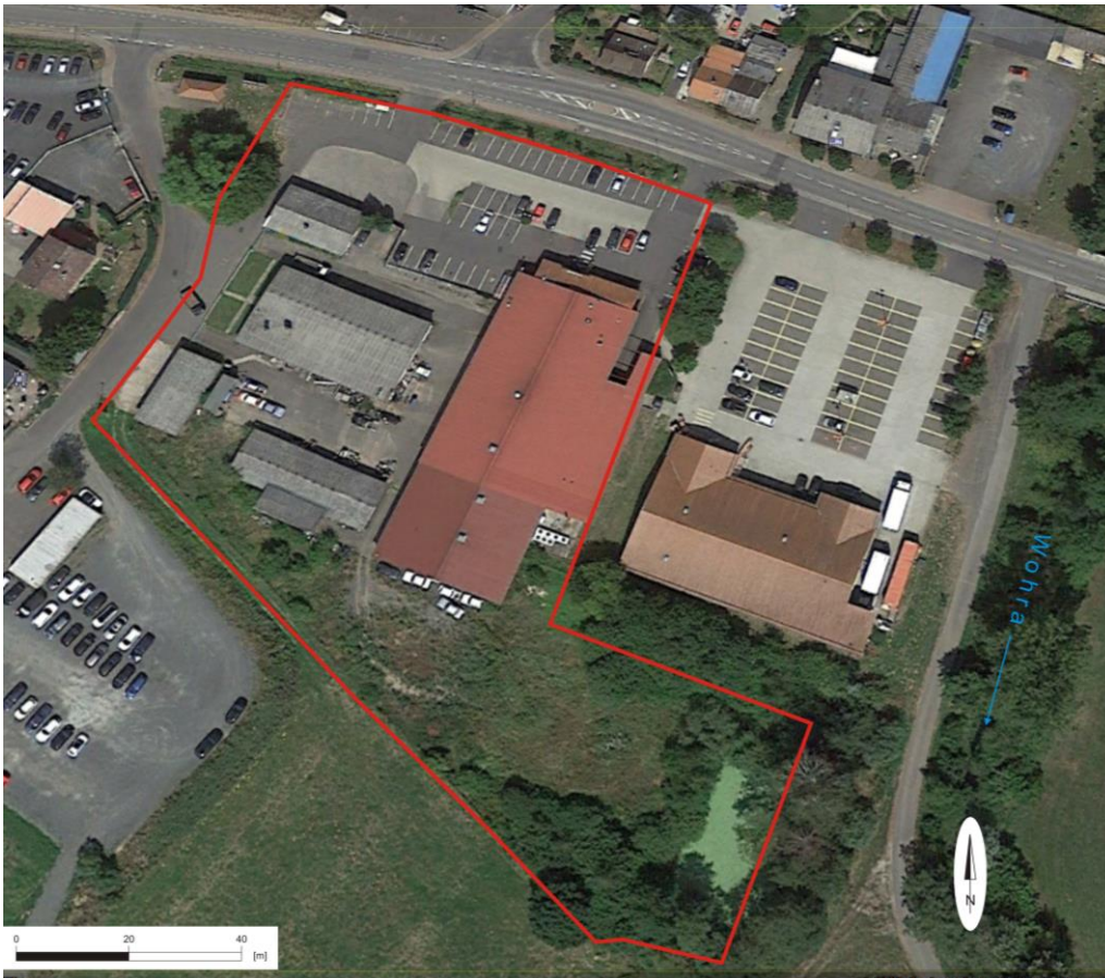
Abbildung 1: Luftbild der Projektfläche (Quelle: „Google Earth“). Am roten Dach zu erkennen ist der aktuelle Fachmarkt bzw. an den grauen Dächern der ab 1963 errichtete Gebäudebestand der ehem. Fa. Junker.
