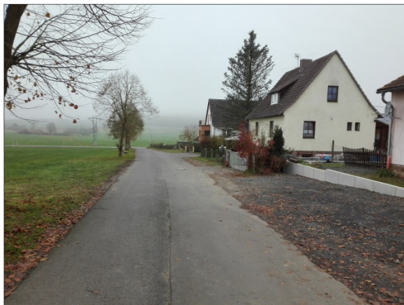
Abb. 7: Blick von Osten nach Westen entlang des Drosselweges mit einzelnen Straßenbäumen (Linden)
