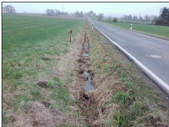
Abb. 5: Straßenbegleitgrün mit Entwässerungsmulde westlich des Plangebietes
