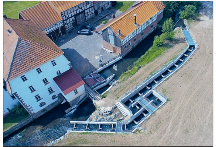
Die 67 m lange Fischaufstiegsanlage überwindet einen Höhenunterschied von 2,40 m. (Foto: Ingenieurbüro Zick-Hessler)
