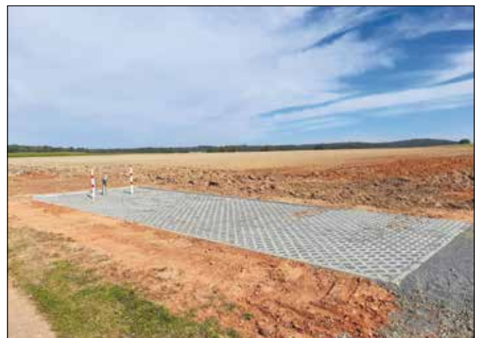
Die neue Löschwasserzisterne in Bracht-Siedlung nach Fertigstellung
