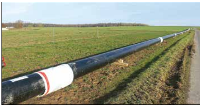
Ein Teil der Verbindungstrasse ist schon vorbereitet.
