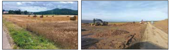
Vorher-Nachher: Wo im Sommer noch geerntet wurde, wird schon bald das Kollektorfeld mit dem Speicherbecken stehen.
