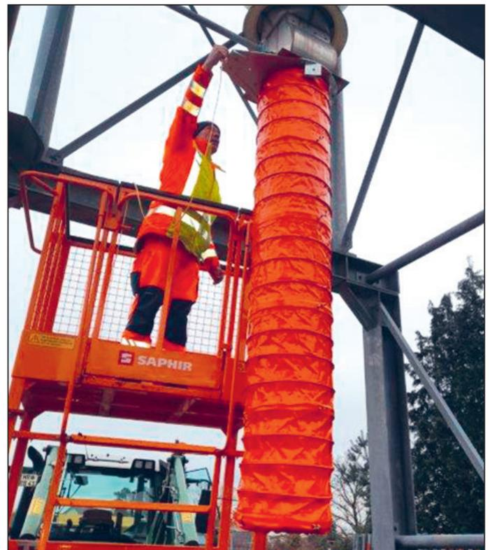
Außerdem hat das Bauhof-Team am Salz-Silo einen neuen höhenverstellbaren Auslass montiert. Derzeit werden das Bedienpodest und ein neuer Aufstieg nach den heutigen Richtlinien in Eigenleistung gefertigt.
