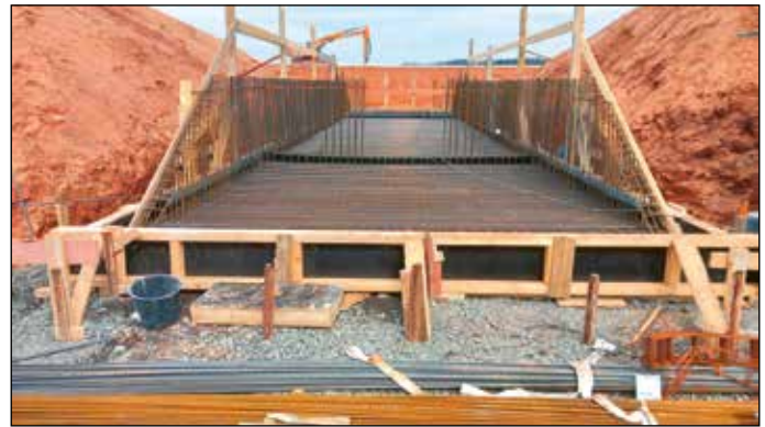
Bewehrungsstahl im Tunnel für die Röhren, die in den Speicher führen. Im Speicher wird das Wasser über Diffusoren verwirbelungsarm ein- und ausgeleitet.
