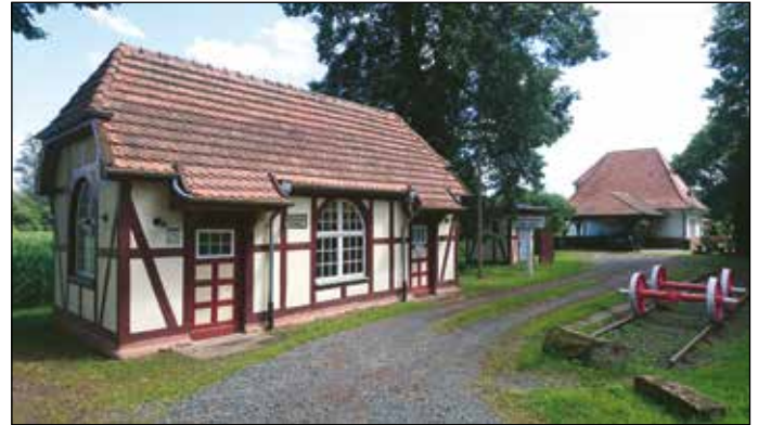
Die Haltestelle Ernsthäuser-Wambach heute mit restauriertem Wartehaus
