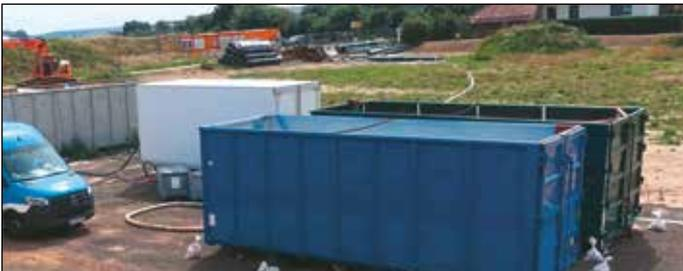
*Umkehrosmose: Das Rohwasser wird zunächst in die beiden Pufferspeicher (grün u. blau) geleitet. Von dort läuft es durch die Umkehrosmose, wird entsalzt, entgast und danach mit Na3PO4 versetzt und schließlich in den Speicher geleitet.*
