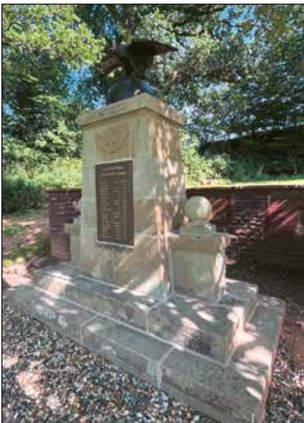
Unser Dank für die fachgerechte und sorgfältige Renovierung gilt den beteiligten Firmen: Fa. Grebing Ernsthausen für die Mauer WK-II und Fa. Bornscheuer Gemünden für das Ehrenmal WK-I. Die Mauer wurde gereinigt, trockengelegt, neu abgedichtet und die Sichtfugen erneuert. Die Mauerabdeckung und weitere 2-3 Steinschichten wurden neu aufgesetzt, dabei musste jeder Stein wieder auf seinen alten Platz. Auch die Arbeit an dem Podest und der großen Säule war ein Puzzle mit
