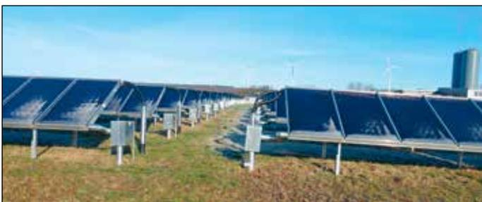
Thermische Solarkollektoren sehen von weitem den Photovoltaikanlagen ähnlich. Dass es sich im Bild (Anlage in Mengersberg, Februar 2022) um Solarthermie handelt, sieht man am besten an den Verrohrungen im Mittelgang.
