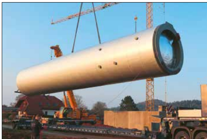
Der Pufferspeicher musste vor dem Aufrichten erst um 180 Grad horizontal gedreht werden.
