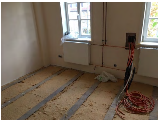
Amtszimmer ohne Boden (links) und mit dem neuen Boden (rechts)
