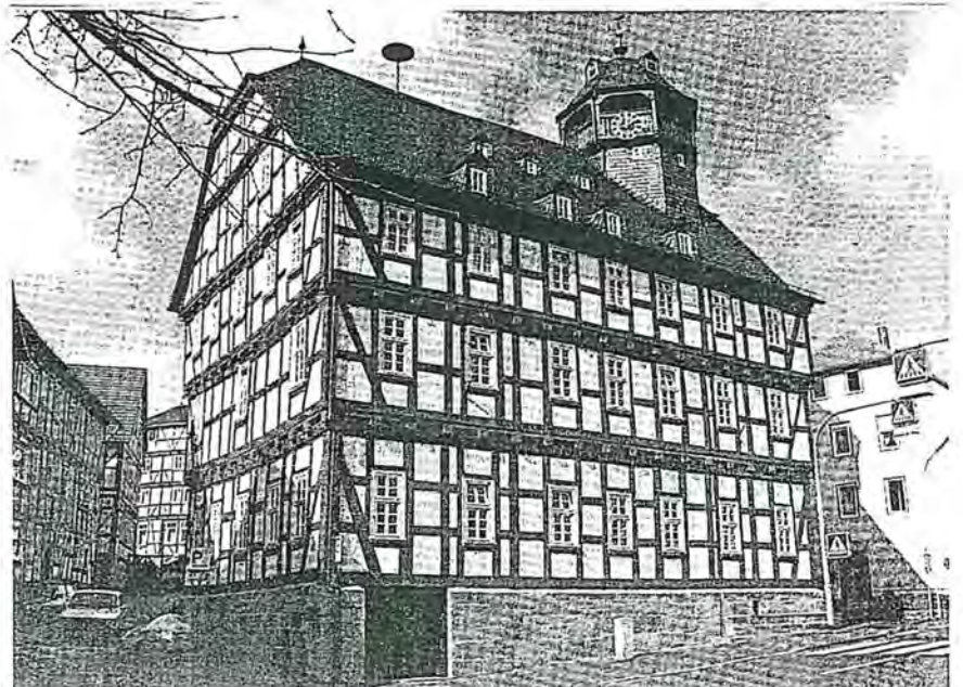
Rathausansicht nach der Renovierung 1985/87
