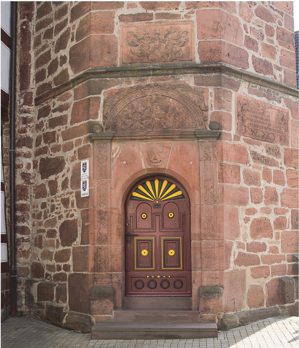
Das von Philipp Soldan 1566 in Stein gestaltete Portal am Eingang zum Rathaus-Turm in Kauschenberg
