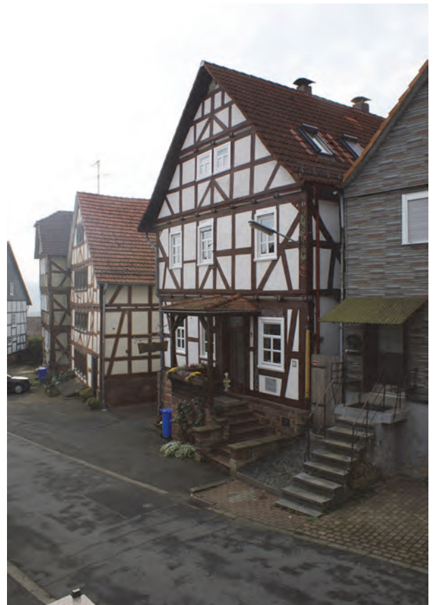
Abb. 7: Blick in die untere Kraftgasse
