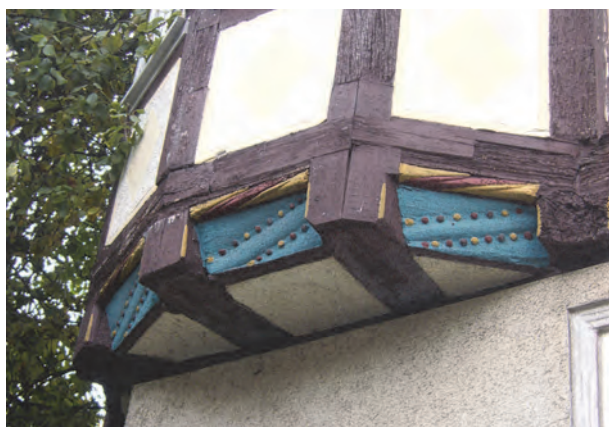
Abb. 12: Reich verziertes Fachwerk an den Erkern
