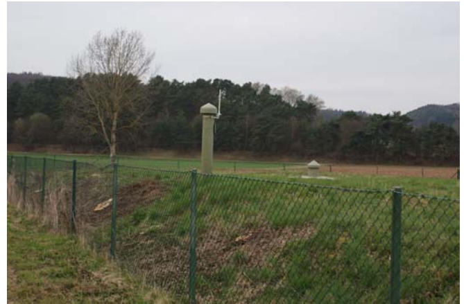
Schiebekammer W7 im Wohratal „In der untersten Struth“, gebaut 1972/73
