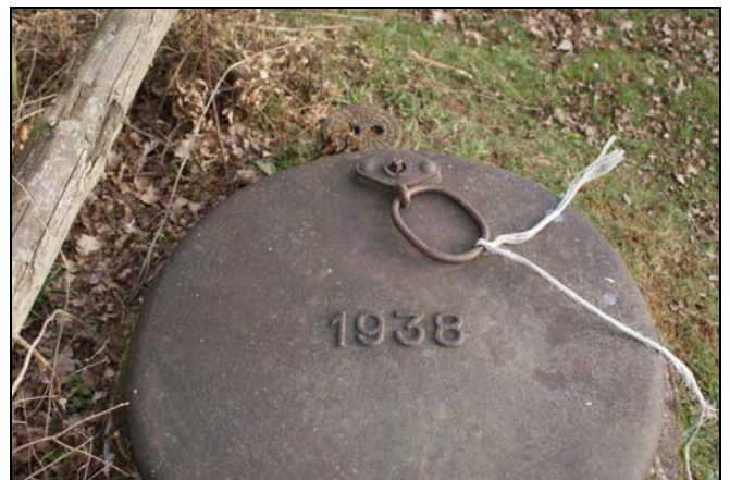
Schacht-Deckel über der Quelle
