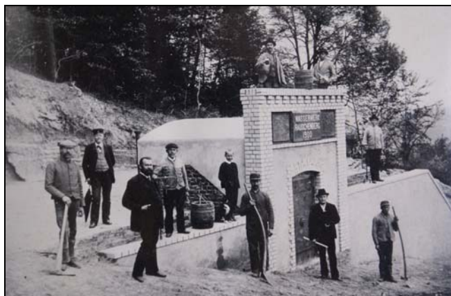
Das neue „Wasserwerk Rauschenberg 1900“
