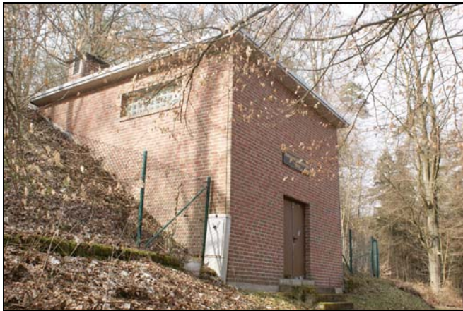
Neuer Hochbehälter auf dem Schlossberg, erbaut 1989/1990
