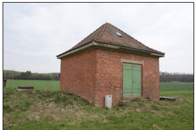
Pumpstation im Wohratal „In der Struth“; erbaut 1948, heute nicht mehr benutzt
