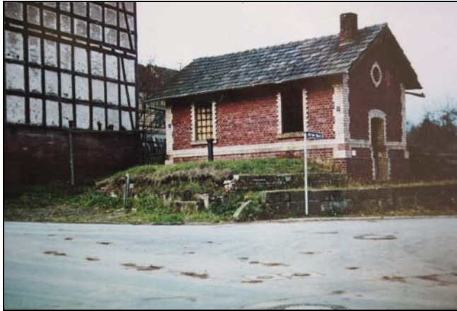
Das Pumpenhäuschen, erbaut um 1900
